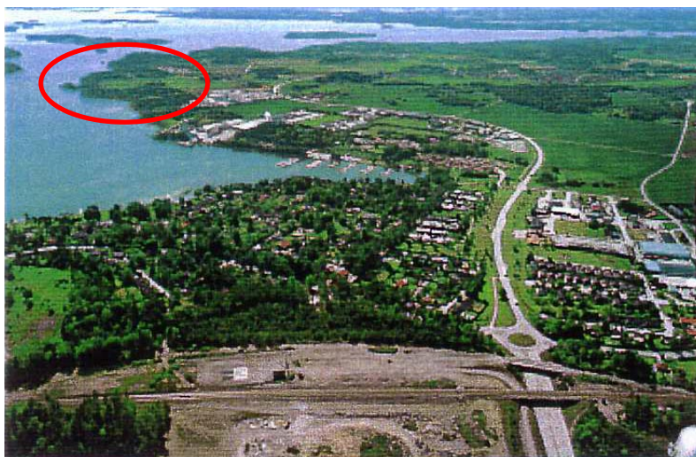
Vy från södra Bålsta mot Frösundavik. En utveckling av tätorten mot Frösundavik kan öka kontakten mellan Mälaren och Bålsta. (Bild ur "Grönstruktur Bålsta")
