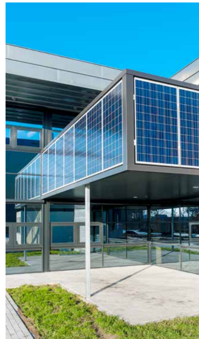
Exempel på solceller på kontorsbyggnad.
